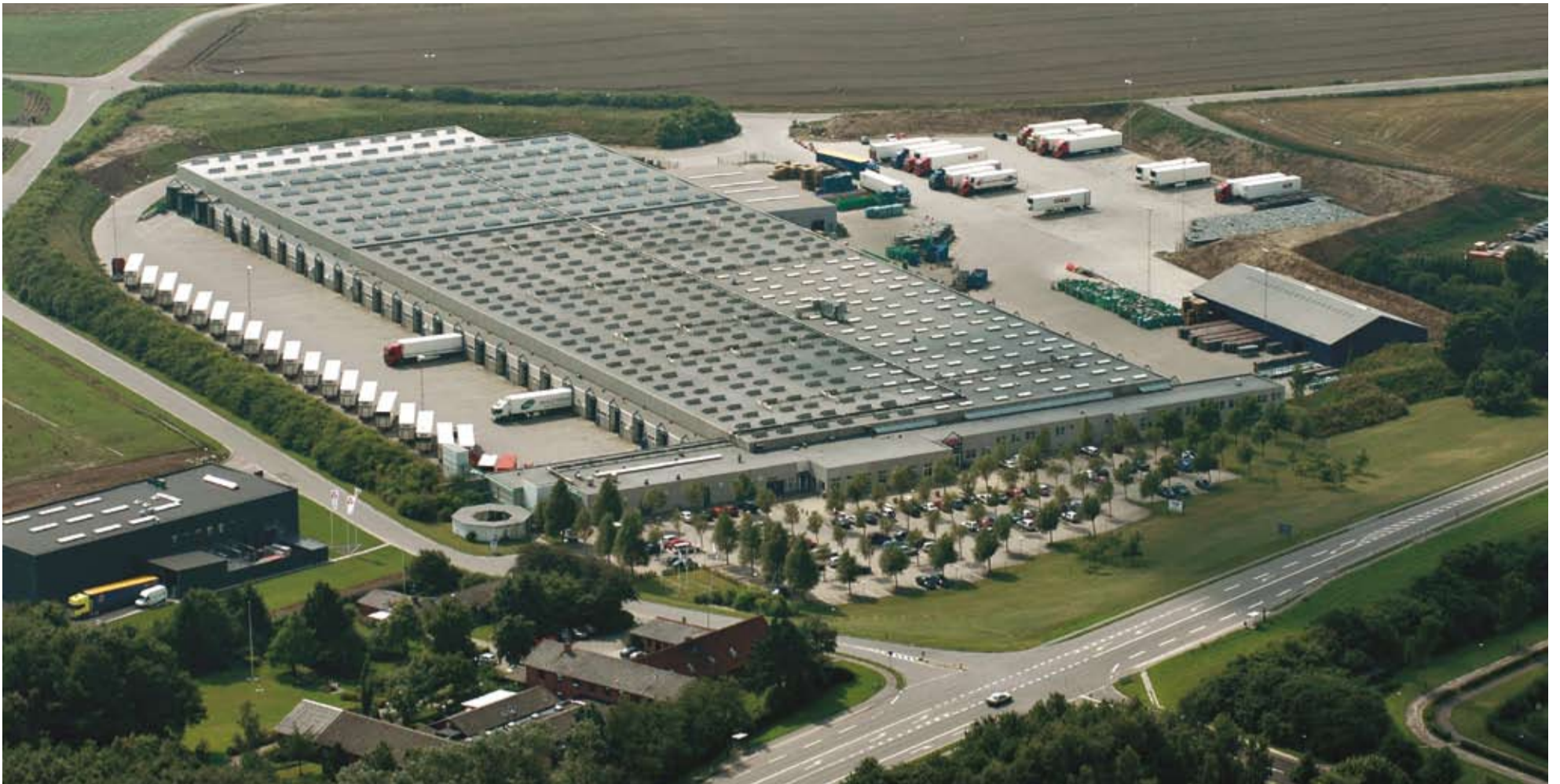
Coop Danmarks Ferskvareterminal i Hasselager er faktisk et kæmpestort kølerum. I slutningen af 2006 blev de gamle standard lysstofrør udskiftet med Aura Lights Thermo Long Life lysstofrør. I alt omkring 900 rør. Foto: Aura Light.
