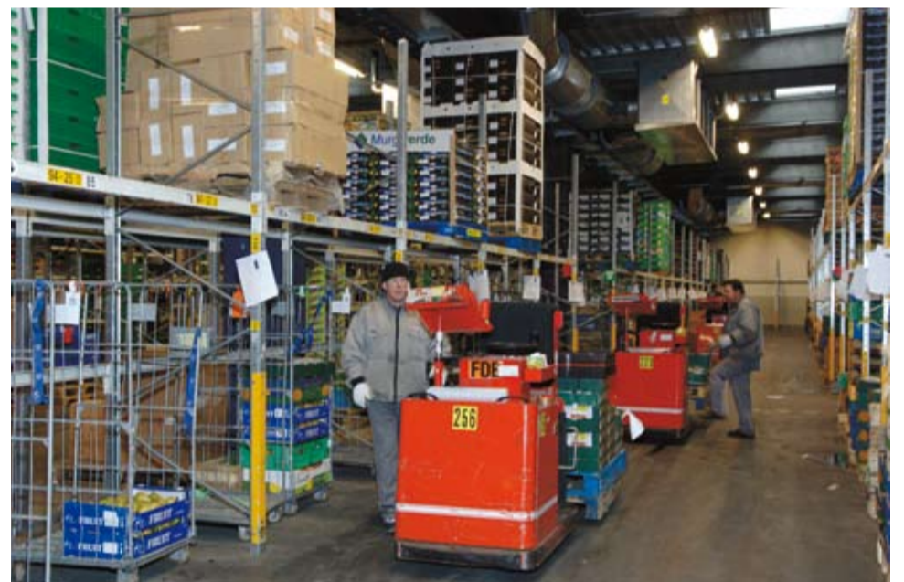
Gaderne mellem lagerreolerne oplyses nu med Thermo Long Life rør. Oprindeligt var armaturerne dimensioneret til og bestykket med tre standard rør, men pga. af det meget højere lysflow i Thermo Long Life røret, har det ene rør kunnet undværes, uden at luxværdien er faldet. Den ligger omkring 200 lux. Foto: Jørgen Jensen. JJ foto.
