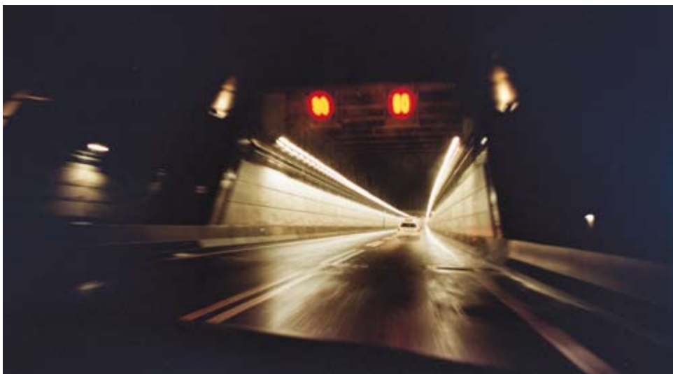
I tunnelen under Øresund sidder 8.200 kvalitetslysstofrør fra Aura.
